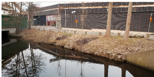
Figur 6.1. Slänt på östra sidan av Mölndalsån, norr om Getebergsleden
